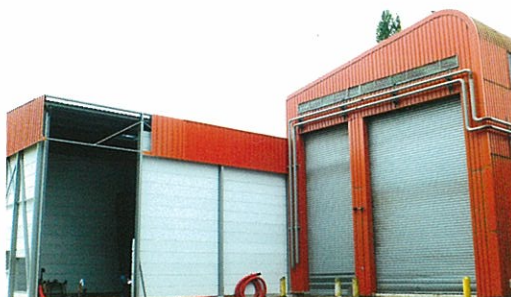
Silo de stockage
