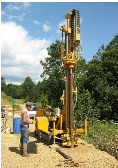
Forage pour la pose d'une des sonde géothermique verticale
