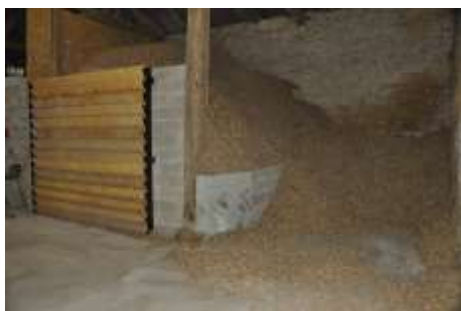
Stockage du bois déchiqueté Crédit photo : ALE 08
