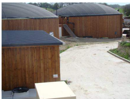
Les digesteurs Crédit photo : Philippoteaux Geoffroy
