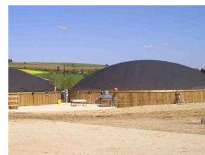
Digesteur et fosse de stockage
