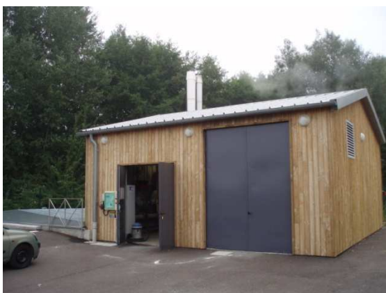
Chaufferie de Piney (Crédit photo : Chambre d'agriculture de l'Aube)
